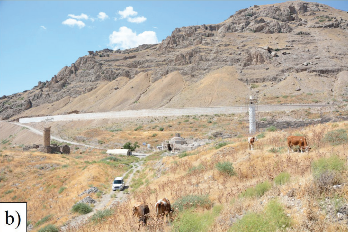
Şekil 6 Çarşıbaşı yerleşim alanının güncel görüntüsü. a) 2010 yılına ait görüntü. En sağda Küçük Camii; Solda Ulu Camii; uzak konumda ise Eski kilise. Eserlerin etek çökelleri tarafından örtüldüğü görülmektedir. b) 2017 yılına ait görüntü. Palu Kalesi eteklerinde gözlenen etek çökellerinin eserlere zarar vermemesi için duvar inşa edilmiştir. Eserler büyük oranda gömülü halden kurtarılmıştır.
